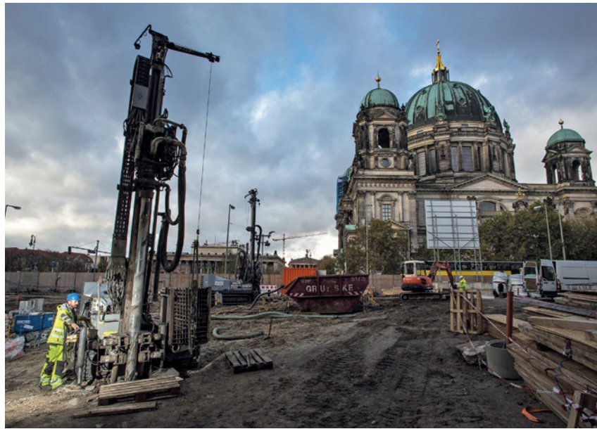
Bild 1. Bohrung für das Erdwärmesondenfeld am Humboldt Forum am Berliner Stadtschloss
