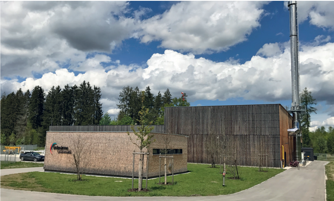
Bild 3. Die Geothermieranlage der Erdwärme Grünwald ist eine von 30 Anlagen, die die hydrothermalen Lagerstätten des bayerischen Molassebeckens nutzen
